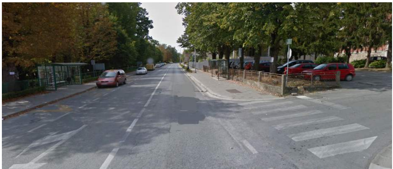
Slika 12. Početak rekonstrukcije dionice D47 u gradu Lipiku-Trg dr. Franje Tuđmana-km 0+000,00
